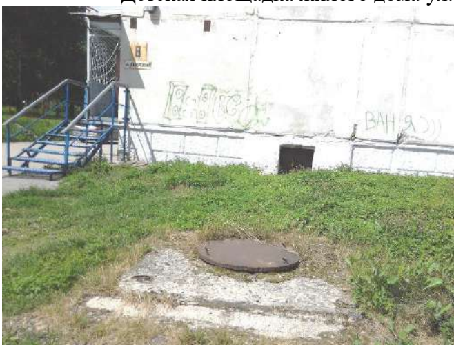
Люк подземных коммуникаций ул. Набережная, д.8, 11.07.2023, 12:44
