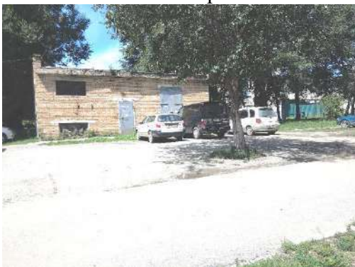
Трансформаторная подстанция жилого дома ул. Набережная, д. 12, 12.07.2023, 13:20
