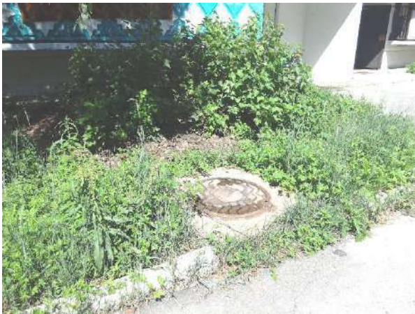
Люк подземных коммуникаций жилого дома, ул. Набережная, 2а, 10.07.2023, 14:27
