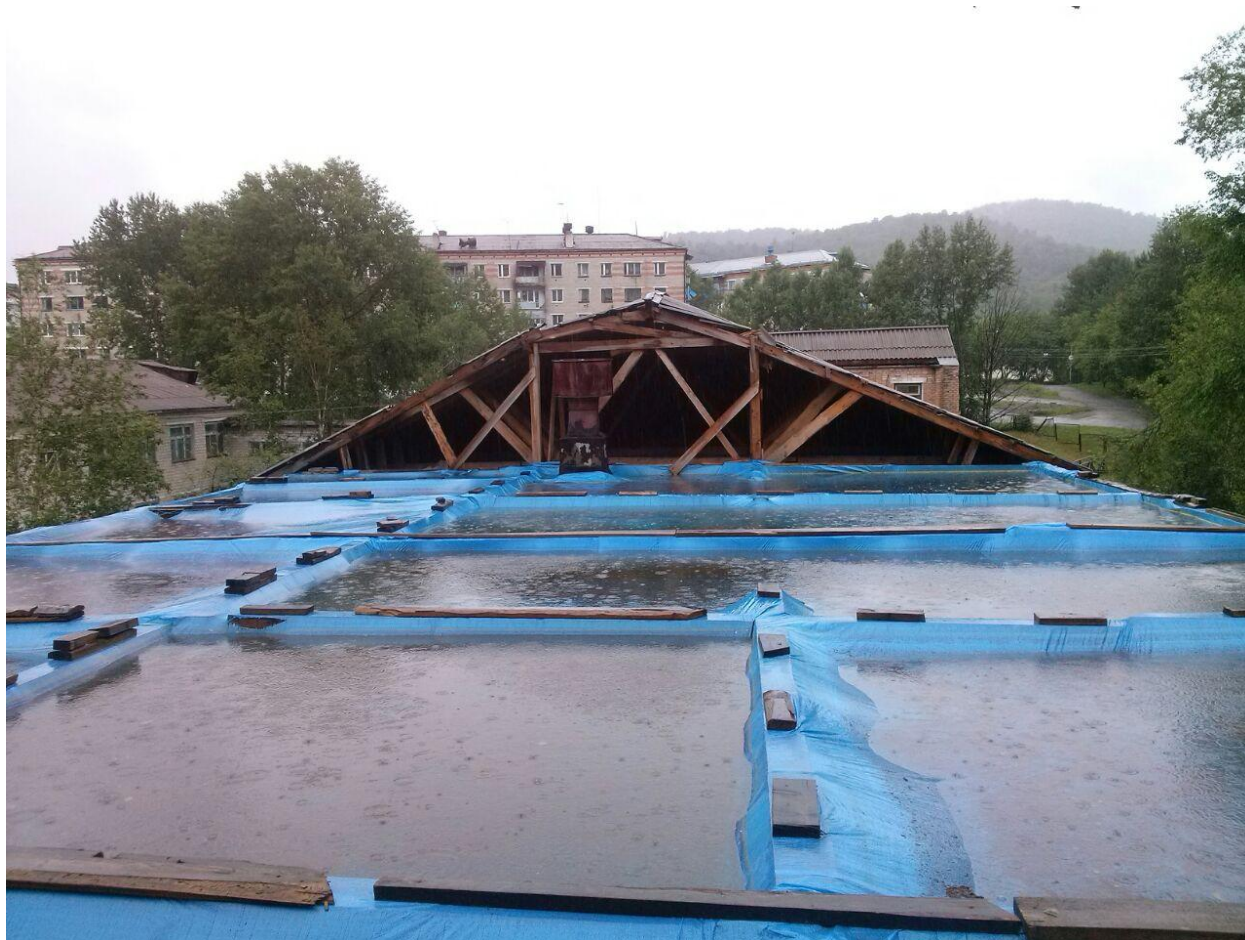
Кровля участковой больницы п. Восток (июль 2015)
